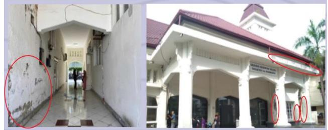
**Gambar 2.** Pengelupasan pada dinding bangunan
