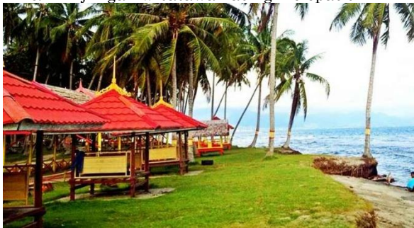
e. Kondisi Gazebo di Lokasi Wisata Pantai
